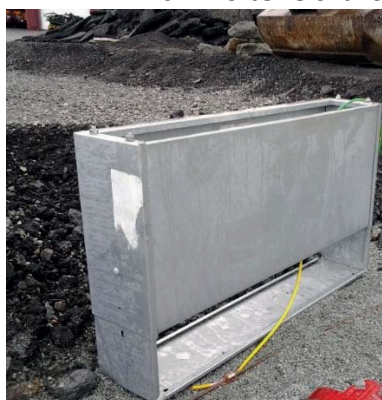
Figur 30. Innføring av isolert jordledning i kabelskap
