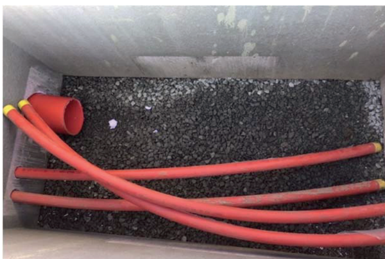
Figur 14. Innføring av rør i firkant kum
