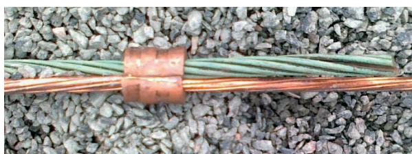
Figur 29. Skjøting av jordledning med C-press
