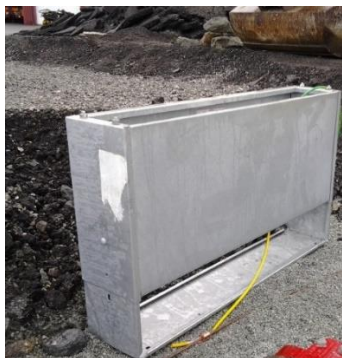
Figur 30. Innføring av isolert jordledning i kabelskap
