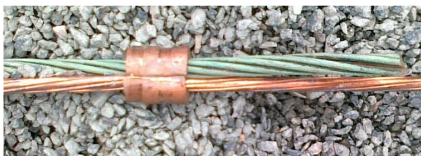
Figur 29. Skjøting av jordledning med C-press
