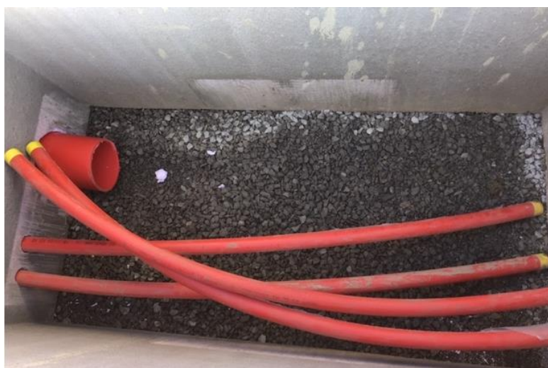
Figur 14. Innføring av rør i firkant kum
