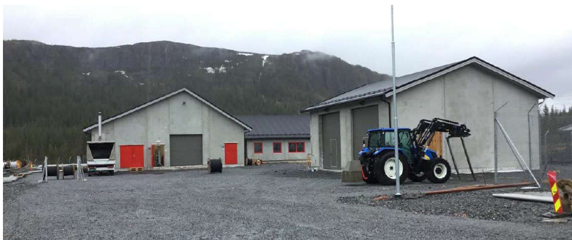
Figur 4: Statnetts standard kontrollbygg og lager/garasje.
