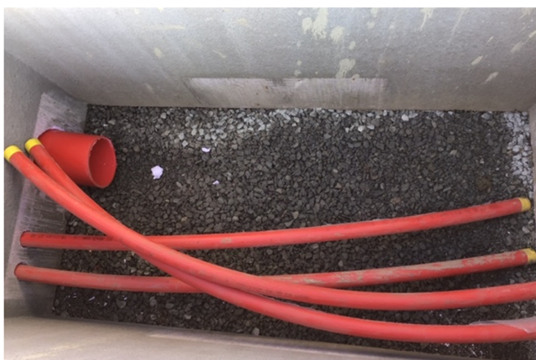
Figur 14. Innføring av rør i firkant kum
