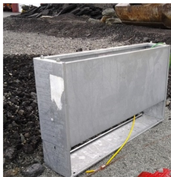
Figur 30. Innføring av isolert jordledning i kabelskap
