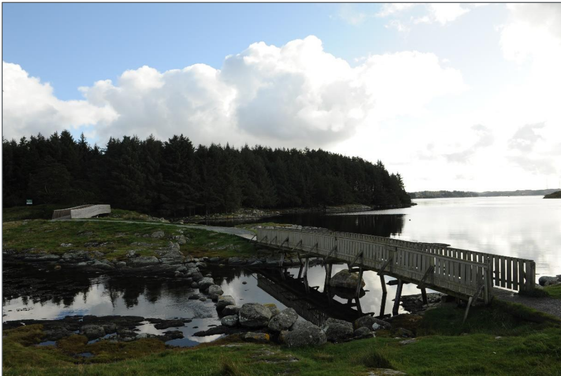
Figur 2-56: God tilrettelegging med broer over til Bukkøy.
