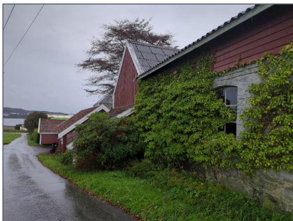
Figur 2-38: Driftsbygning på Utvik.
