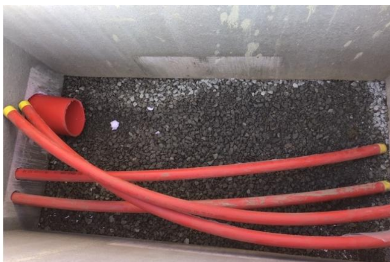
Figur 17. Innføring av rør i firkant kum
