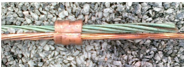
Figur 32. Skjøting av jordledning med C-press
