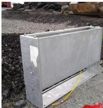
Figur 33. Innføring av isolert jordledning i kabelskap
